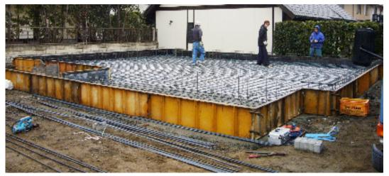
基礎はシングル鉄筋のベタ基礎。鉄筋を切断しますので換気口は作らずロングキソパッキンを桧の土台の下にひくことで代用します。基礎の立ち上がりはGLから 480 mm。立ち上がりの幅は4寸(120 mm)の土台を受ける為に 150 mmをとっています。 2月の寒冷中なので凍結による気泡ができないかと心配していましたけれど、それもなくきれいに仕上がっていました。岡山の県南でしたら、基礎を作るのに余り季節は関係ないでしょう。ちなみに北海道などでは夏場に基礎を作りひと冬越させると聞いたことがあります。
